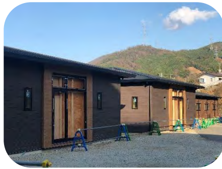
建設中の新ユニット
